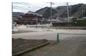
工事中の平成福祉会 新進入路
